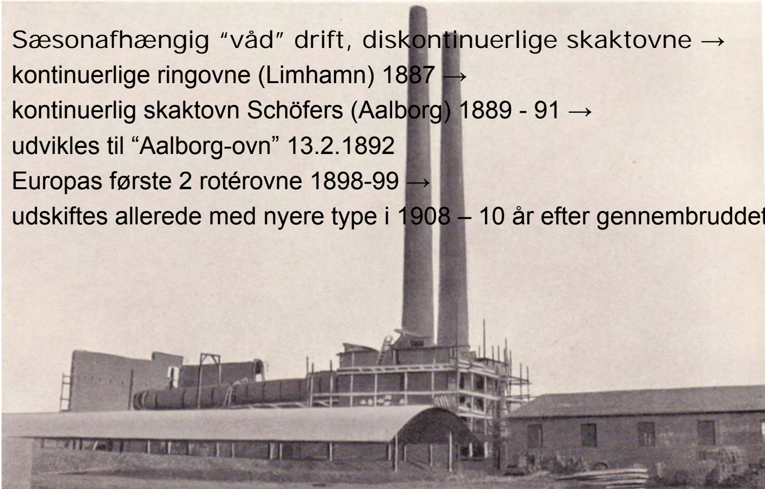
Den nye roterovnsbygning under opførsel - 1914
