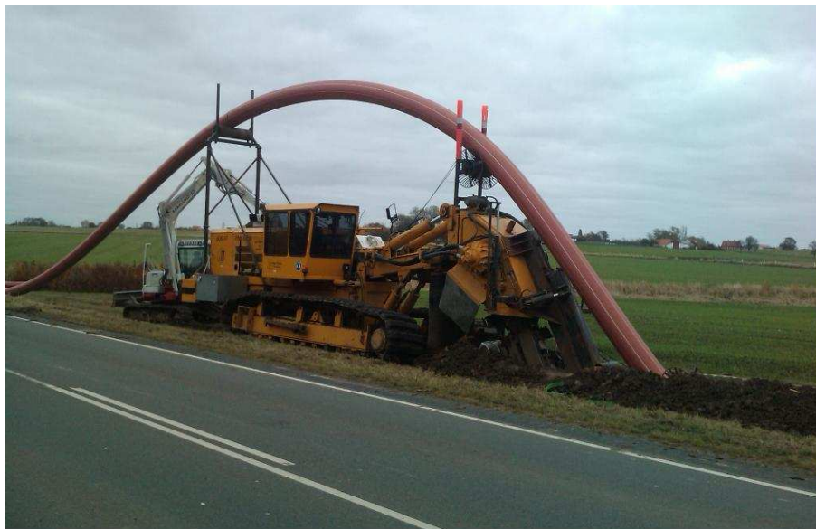
Etablering af trykledning fra Næsby Strand til Korsør Renseanlæg efteråret 2009
